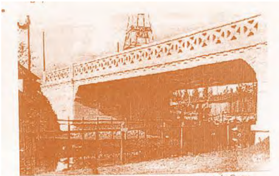
Primul pod proiectat și executat din beton armat de Gogu Constantinescu în 1906
